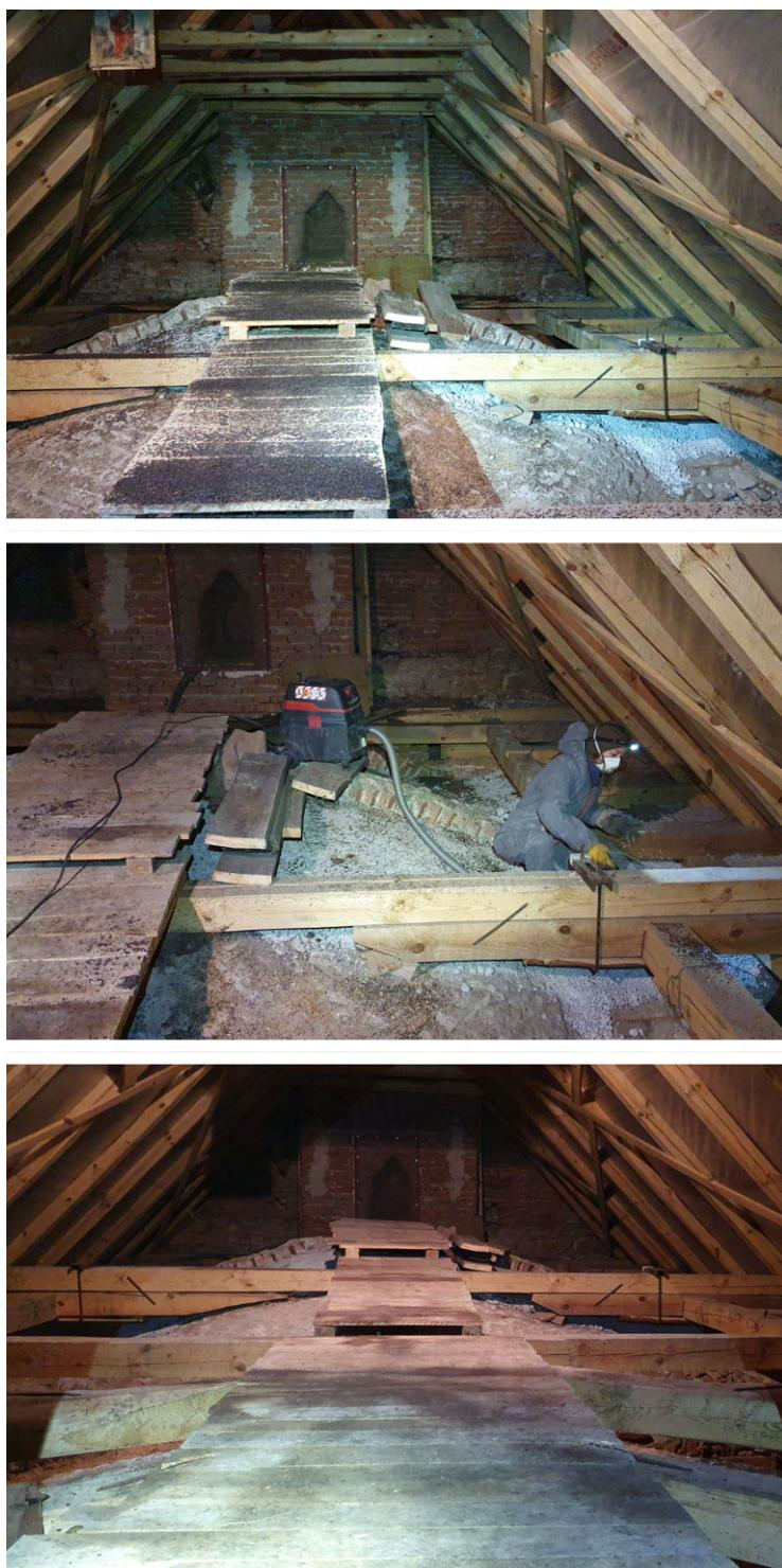
Obr. 6.19: Pôchodzna lávka a jej okolie znečistená od guána (↑). Použitie priemyselného vysávača - praktickej pomôcky na čistenie takto málo znečistených priestorov (stred). Výsledný stav po vyčistení podkrovia a povysávaní lávky (↓).
