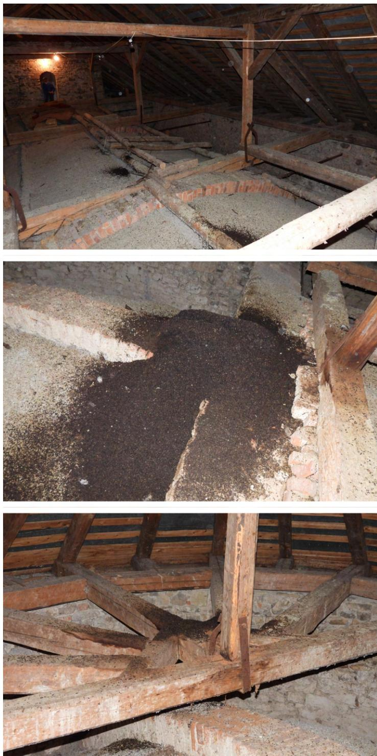
Obr. 6.30: Pôvodný stav znečistenia izolácie guánom. Čistenie tohto priestoru je prakticky nemožné.
