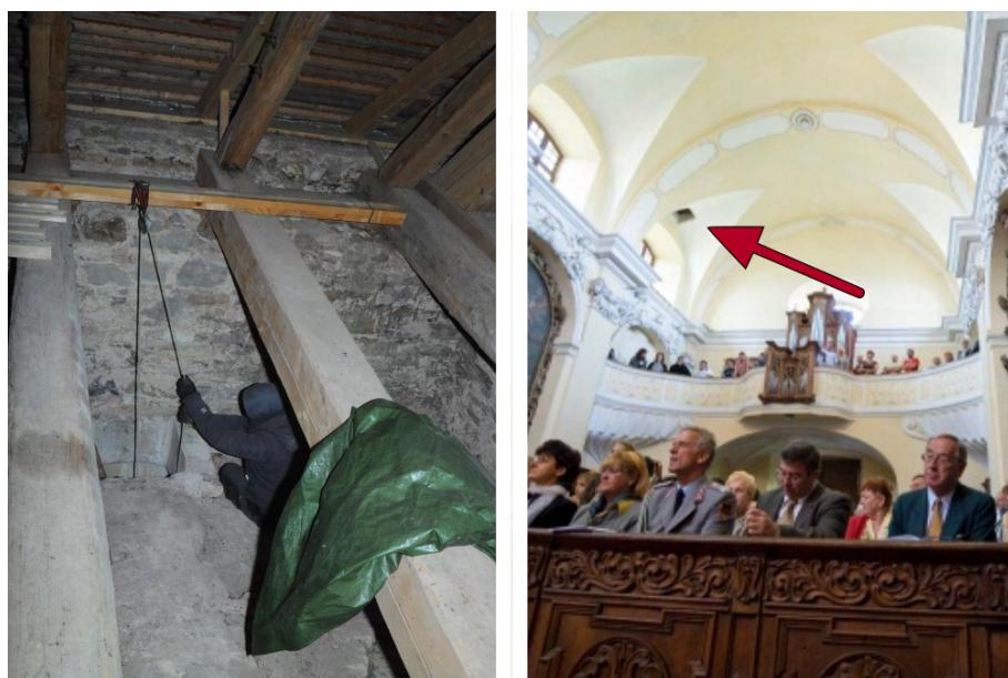
Obr. 6.1: Veľmi ľahké bolo dostať materiál na podkrovie cez malý otvor v klenbe nad chórom. To sa podarilo pomocou kladky a jednej osoby na parapete okna, ktorá navádzala dosky, aby otvorm v klenbe prechádzali uhlopriečne.
