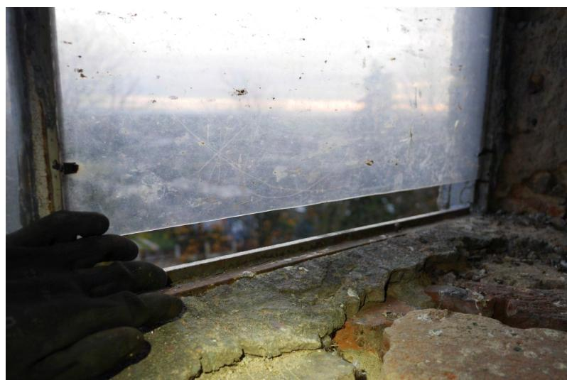
Obr. 6.42: Vletový otvor zmenšený plexisklom.
