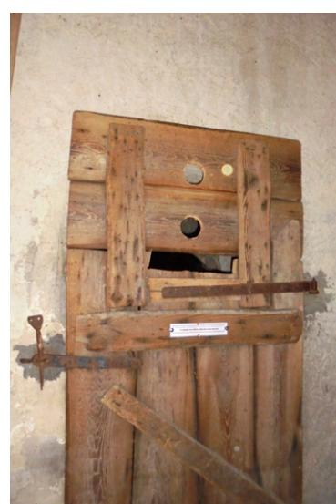
Obr. 6.37: Vletové otvory umiestnené do dverí.
