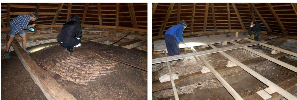
Obr. 6.26: Pôvodný stav znečistenia klenby a jej okolia od guána (←). Základy pokladania podlážky a prispôsobenie jej výšky nad klenbu (→).
