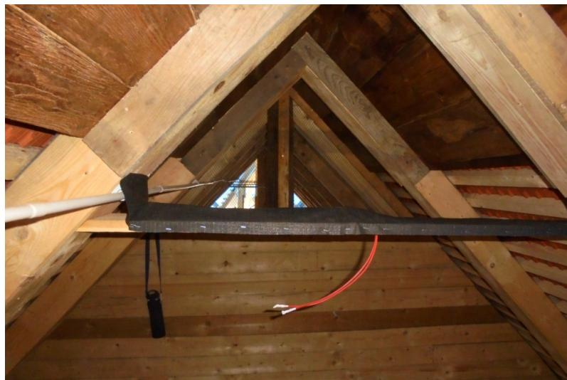
Obr. 6.47: Elektroinštalácia, protipožiarne čidlá — pokial' sú inštalované pod netopiermi, tak sa veľmi zle upratujú. Je preto vhodné prekryť ich DTB fóliou (Horná Police; CZ).
