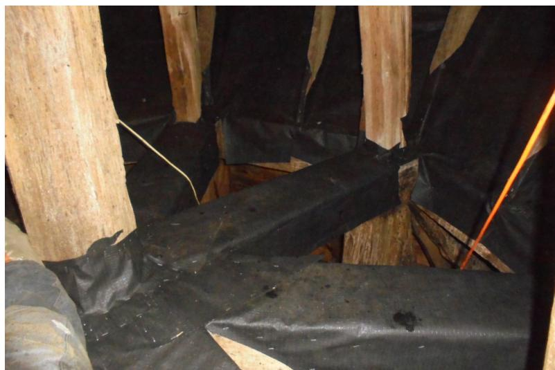
Obr. 6.11: V najvyššej úrovni veže sú trámy pokryté DTB fóliou, rovnakým spôsobom je ochránené aj debnenie cibule veže v spodnom oblúku.
