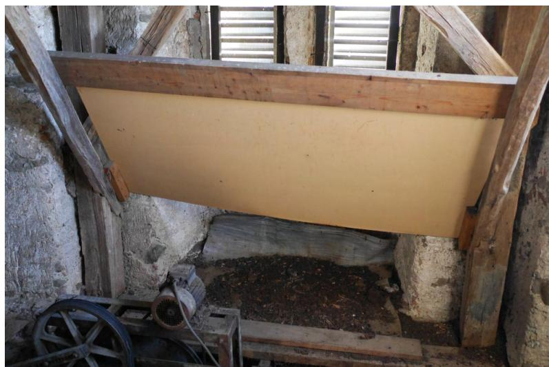
Obr. 6.48: Pri menších kolóniach alebo v malých priestoroch veží postačí odkloniť dopad trusu. V tomto prípade padá guáno netopierov veľkých z otvoru na klenbe vo veži kostola na podlahu, kde sa nachádza mechanizmus zvonov. Doska slúži na odklonenie dopadu trusu mimo tieto konštrukcie – takto sústredený trus je možné aj ľahšie odstrániť (Vyšná Kamenica; SK).
