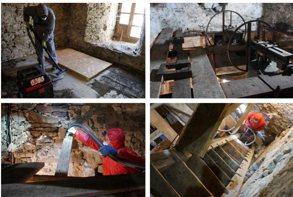
Obr. 6.21: Dôkladné čistenie pomocou priemyselného vysávača.
