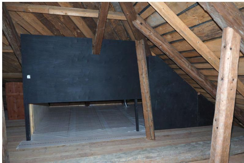
Obr. 6.52: Jeden typ mikoprístrešku v podkroví opátstva v podobe malého vstavaného priestoru vo veľkom podkroví, podlaha je chránená pred guánom paropriepustnou fóliou (Szczyrzyc; PL).
