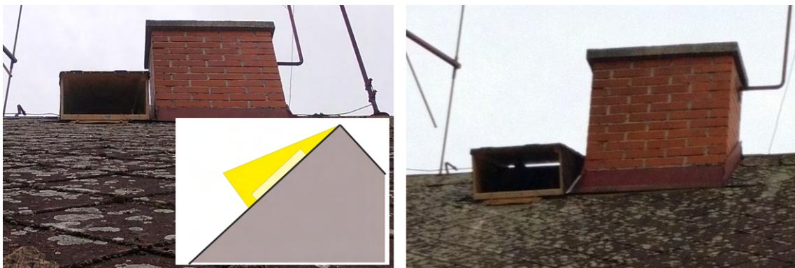
Obr. 6.34: *Odklápací vikier umožňuje prístup netopierov do podkrovia.*
