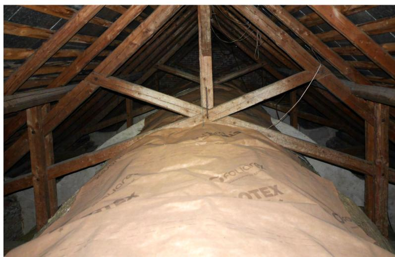
Obr. 6.29: Pôvodný stav znečistenia izolácie od guána. Čistenie tohto priestoru je prakticky nemožné (↑). Vol'ne položená paropriepustná fólia, ktorá oddelí padajúce guáno od izolácie a ul'ahčí čistenie do budúcna (↓).
