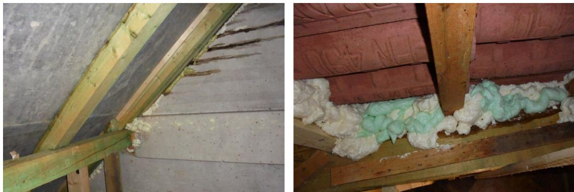
Obr. 6.16: Všetky škáry sme utesnili pomocou polyuretanovej peny, a to aj medzi štítom a škridlami. Takto sa netopiere nemôžu v žiadnom prípade dostat' do priestoru podkrovia.
