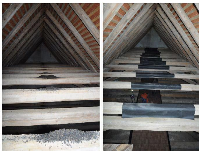
Obr. 6.4: Netopiere často visia na trámoch pod hrebeňom, preto sa veľké množstvo trusu zachytí na hambálkoch (←). Jednoduchá ochrana hambálku pomocou pruhu DTB fólie prichytenej k trámu pomocou sponkovačky (→).
