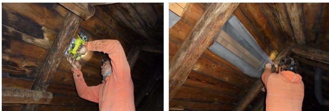
Obr. 6.17: Prerezanie pôvodného debnenia pomocou priamočiarej píly (←). Bolo potrebné prerezať a zaistíť paropriepustnú fóliu (→).
