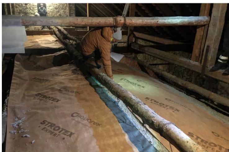
Obr. 6.31: Prekrytie fúkanej izolácie paropriepustnou fóliou – oddelí padajúce guáno a umožní čistenie.
