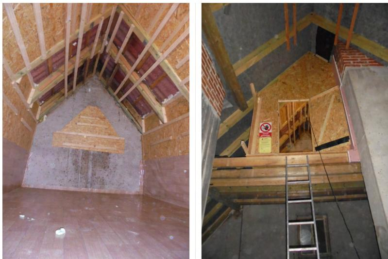
Obr. 6.15: Vnútorný priestor búdy, kde je podlaha zakrytá linoleom a v hornej časti sú pre netopiere pripravené laty na zavesenie. Zadná časť je teplejšia a sú v nej odkryté škridle, v prednej časti je strop býky zakrytý OSB doskami tak, že za nimi prúdi vzduch — to spoločne s múrom komína túto časť ochladzuje (←). Pohľad na umiestnenie býky na hambálkoch v podkroví. Inventarizačný otvor sa uzatvára a je zaistený visiacim zámkom (→).
