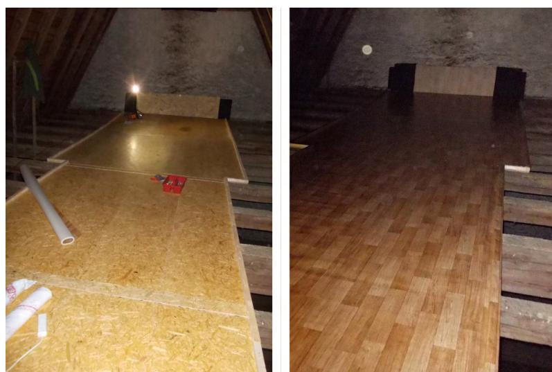
Obr. 6.5: Podlážka zložená z OSB dosiek položená na trámoch. Zvýšený okraj bol vytvorený pred položením linolea (←). Dokončená podlážka s mäkkým linoleom ohnutým cez zvýšený okraj. Na fotke je vidieť aj šikmý koniec podlážky pri šítovej stene (→).
