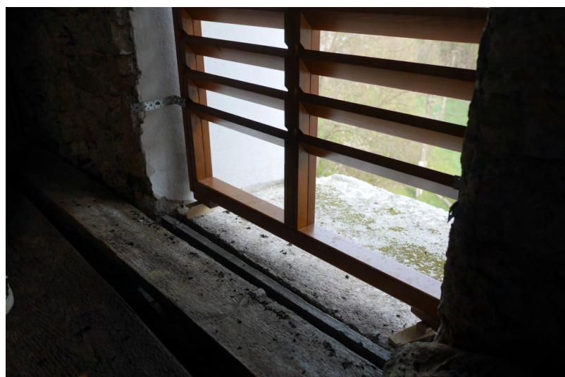
Obr. 6.40: Vletový otvor v nových okenných žalúziach (dopredu naplánovaný).
