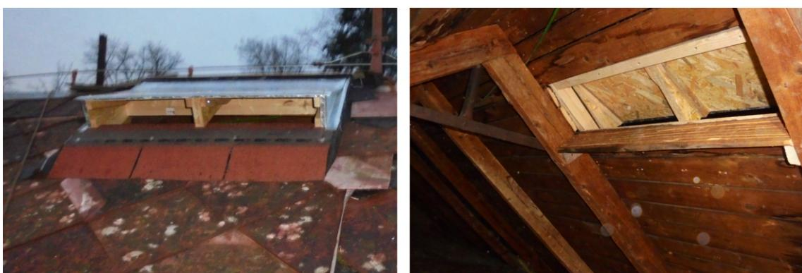
Obr. 6.35: *Vikier ako náhrada za zaniknutý vletový otvor.*
