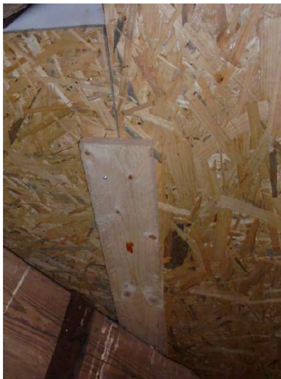
Obr. 3.7: Zvlak spevňuje dosky v mieste spoja. Tvorí ho väčšinou doska umiestnená pod podlahu v mieste spojenia dosiek priskrutkovaná k obom spájaným doskám.
