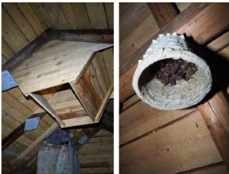
Obr. 6.53: Ďalší typ mikroprístrešku inštalovaný v bývalej základnej škole v podobe vybudovaného priestoru v štíte strechy zabezpečuje stabilnú mikroklímu a tmu vo veľkom a presvetlenom podkrovnom priestore (←; Wojkova; PL). Mikroprístrešok "luster" v podkroví kostola vyrobený z keramického hrnca, ktorý obľubuje najmä netopier brvitý (→; Jaworzna; PL).
