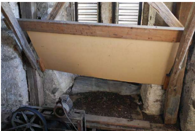
Obr. 6.48: Pri menších kolóniách alebo v malých priestoroch veží postačí odkloniť dopad trusu. V tomto prípade padá guáno netopierov veľkých z otvoru na klenbe vo veži kostola na podlahu, kde sa nachádza mechanizmus zvonov. Doska slúži na odklonenie dopadu trusu mimo tieto konštrukcie – takto sústredený trus je možné aj ľahšie odstrániť (Vyšná Kamenica; SK).
