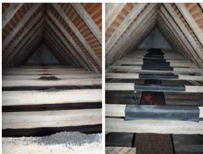
Obr. 6.4: Netopiere často visia na trámoch pod hrebeňom, preto sa veľké množstvo trusu zachytí na hambáľkoch (←). Jednoduchá ochrana hambáľku pomocou pruhu DTB fólie prichytenej k trámu pomocou sponkovačky (→).
