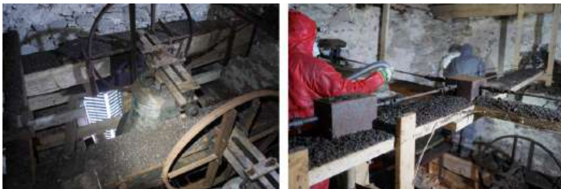
Obr. 6.20: Pôvodný stav — znečistenie guánom je závažné a poškodzuje drevené konštrukcie a mechanizmus zvonov.
