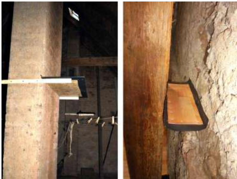
Obr. 6.45: Netopiere sa v horúcich dňoch radi chladia na stenách a na stenách komínov. Na zníženie množstva guána na podlahe sa dá na komín pripevniť OSB doska pomocou lát a hmoždiniek (Vysoké Veselí; CZ; ←). Ak je stojka príliš blízko pri stene a je problém za ňou upratovať, môžeme si v mieste, kde sa medzera rozširuje, pomôcť prídavnou doskou (Horná Police; CZ; →).
