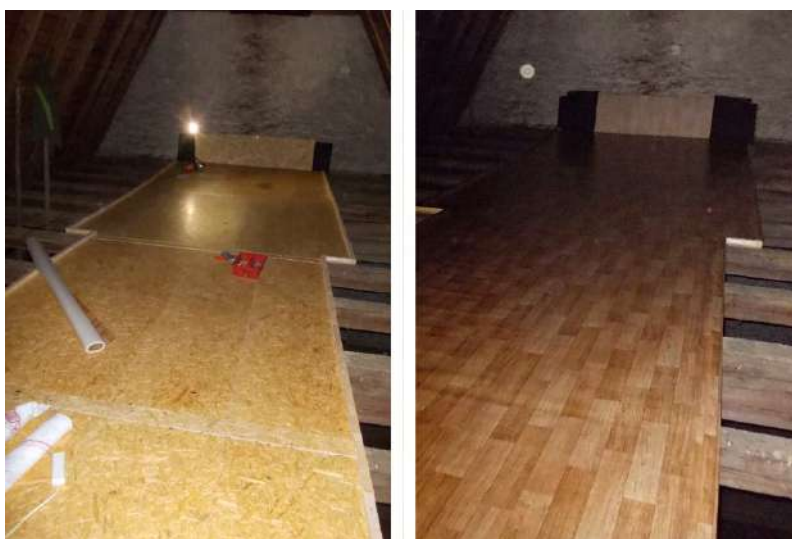
Obr. 6.5: Podlážka zložená z OSB dosiek položená na trámoch. Zvýšený okraj bol vytvorený pred položením linolea (←). Dokončená podlážka s mäkkým linoleom ohnutým cez zvýšený okraj. Na fotke je vidieť aj šikmý koniec podlážky pri štítovej stene (→).
