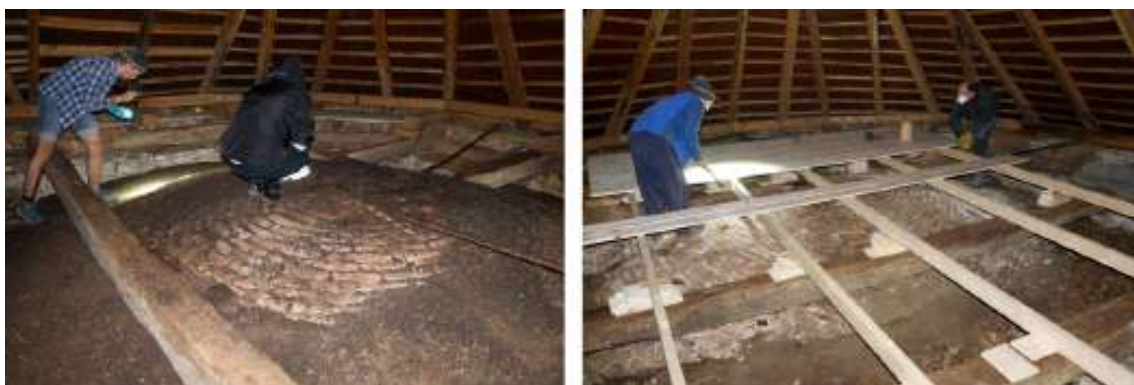
Obr. 6.26: Pôvodný stav znečistenia klenby a jej okolia od guána (←). Základy pokladania podlažky a prispôbenie jej výšky nad klenbu (→).
