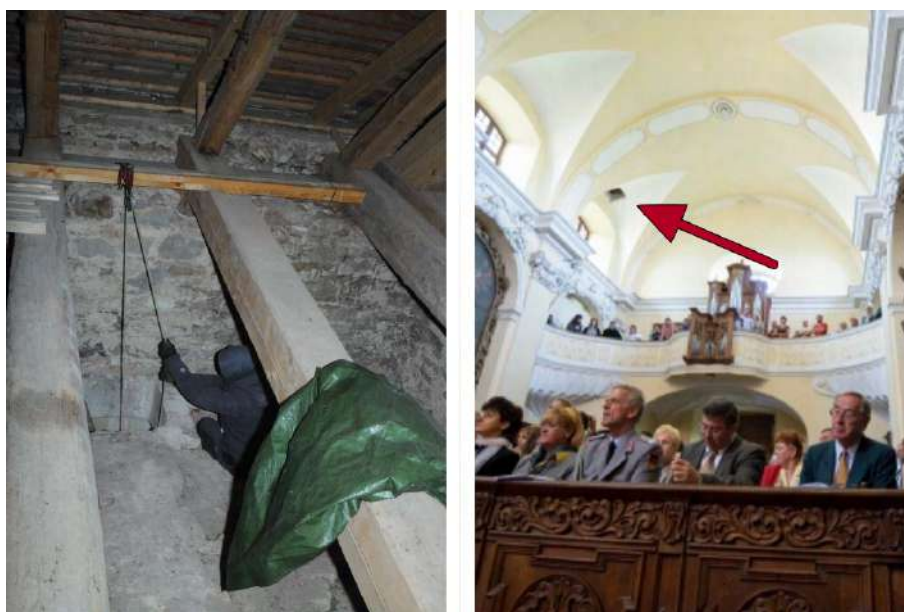
Obr. 6.1: Veľmi ťažké bolo dostať materiál na podkrovia cez malý otvor v klenbe nad chórom. To sa podarilo pomocou kladky a jednej osoby na parapete okna, ktorá navádzala dosky, aby otvorom v klenbe prechádzali uhlopriečne.
