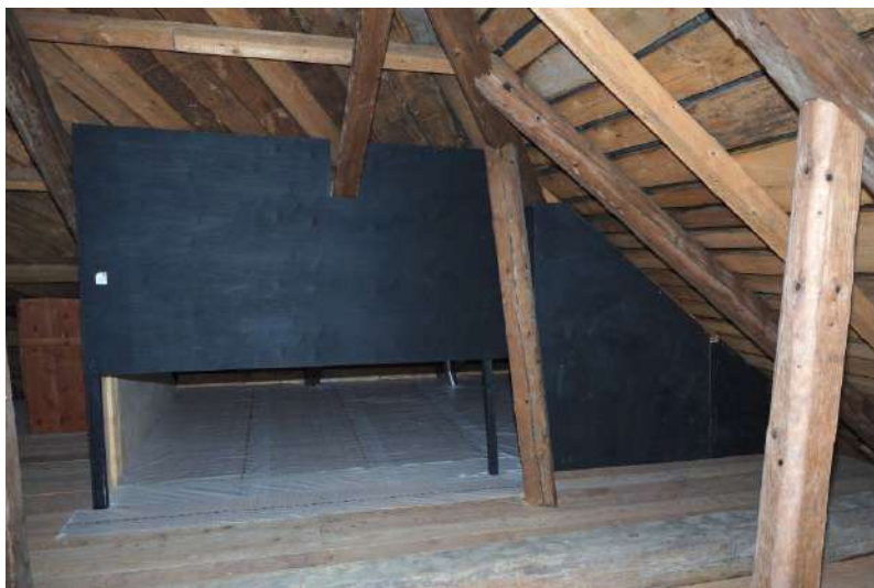
Obr. 6.52: Jeden typ mikroprístrešku v podkroví opátstva v podobe malého vstavaného priestoru vo veľkom podkroví, podlaha je chránená pred guánom paropriepustnou fóliou (Szczyrzyc; PL).
