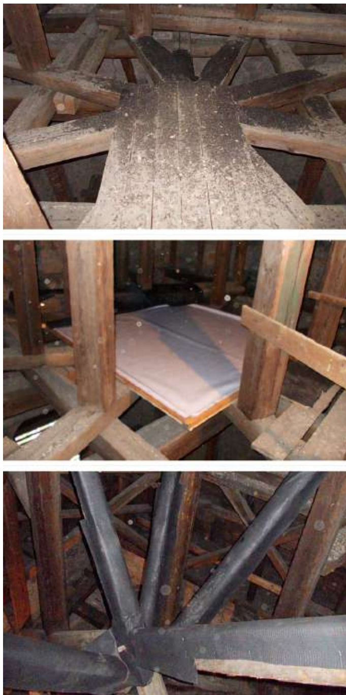
Obr. 6.8: Pôvodný stav (↑). Veľmi jednoduchá podlážka, potiahnutá bielym linoleom, ktorá zachytí väčšinu trusu (stred) Nad podlahou sa však ešte nachádza spleť vzpier, ktoré museli byť na ochranu pred guánom ochránené pásmi DTB fólie (↓).
