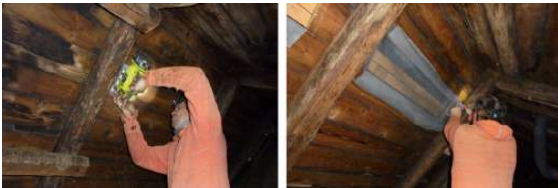
Obr. 6.17: Prerezanie pôvodného debnenia pomocou priamočiarej píly (←). Bolo potrebné prerezať a zaistiť paropriepustnú fóliu (→).
