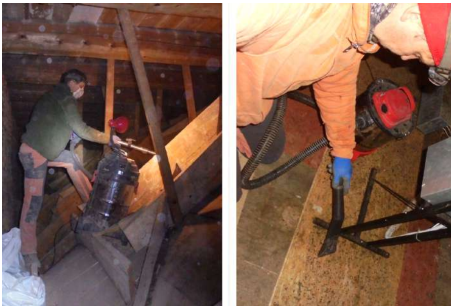
Obr. 1.6: Ukážky upratovania guána po netopieroch. Vysávanie trusu uchádza svetlého pomocou malého krbového vysávača (←). Vysávanie trusu podkovára malého pomocou vysávača Hecht z drevenej klenby kostola (→). Môžete si všimnúť použitie štípcovej lampičky pripnenej o rukoväť vysávača a napájanej zo zásuvky na vysávači.
