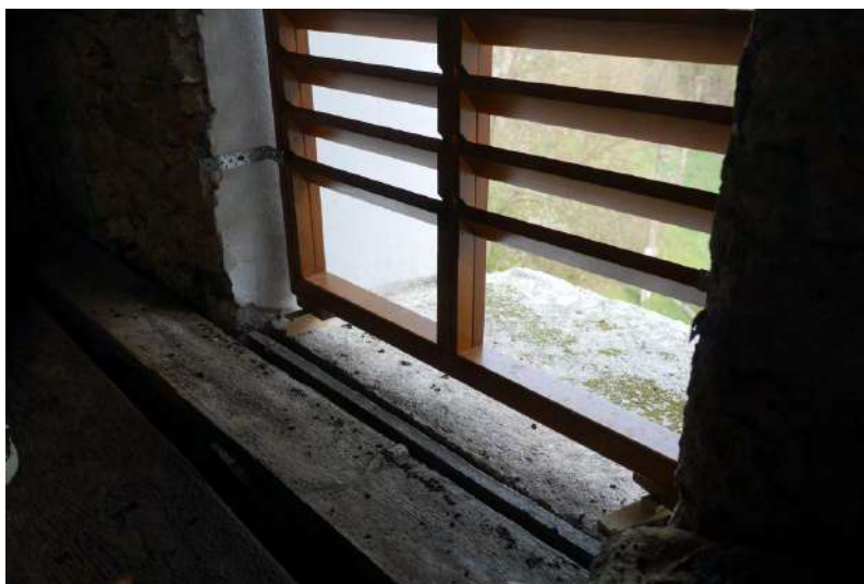
Obr. 6.40: Vletový otvor v nových okenných žalúziách (dopredu naplánovaný).
