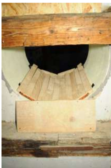
Obr. 6.32: Drevený latový rošt v kruhovom okne.
