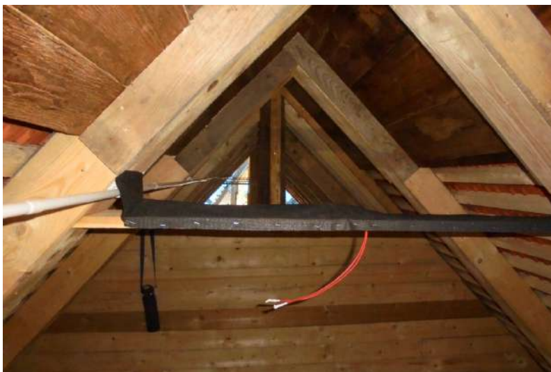
Obr. 6.47: Elektroinštalácia, protipožiarne čidlá — pokiaľ sú inštalované pod netopiermi, tak sa veľmi zle upratujú. Je preto vhodné prekryť ich DTB fóliou (Horná Police; CZ).
