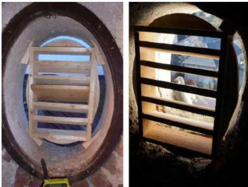
Obr. 6.36: Vložka so žalúziami z nehol'ovaných dosiek. Rovnaké riešenie, ktoré efektívne zamedzilo vletu holubov, bolo realizované v podkroví kostola v obci Rožňavské Bystré (SK; →).
