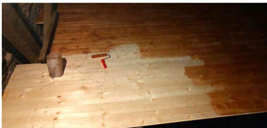
Obr. 3.8: Podlážka budovaná vo veži kostola, kde dochádzalo k silnému znečisteniu konštrukcií a zvonov guánom. Hranoly postavené na výšku boli použité ako základný rošt, na ktorý bola pokladaná masívna smreková dlážkovica s perodrážkou (↑). Odnímateľná časť podlážky umožňuje ľahký prístup na miesta, kde je nutná pravidelná kontrola či servisné práce (stred). Podlážky z masívnych dosiek a dlážkovice nemusíme prekrývať linoleom a fóliami — je možné ich ošetriť zdravotne nezávadným ochranným povrchovým náterom (↓).
