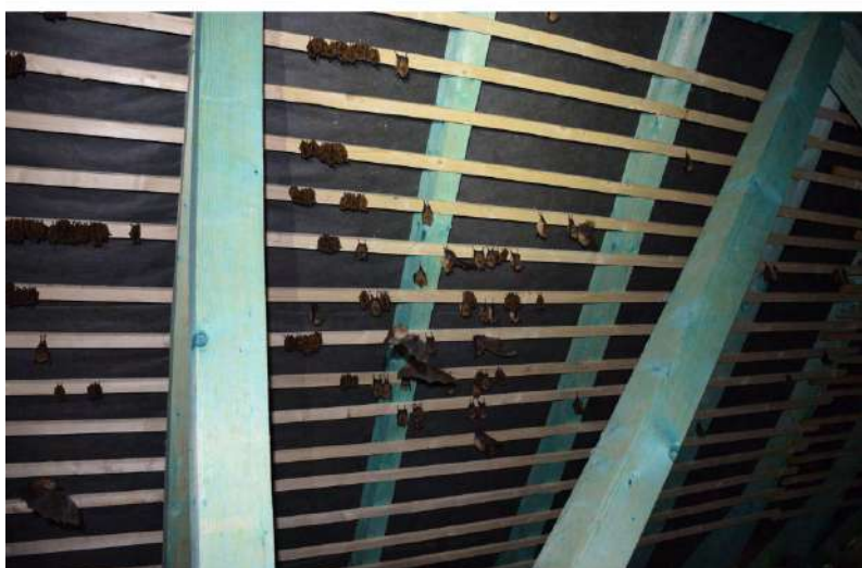
Obr. 6.50: Výber stanovišť a pre netopiere v podkroví je možné usmerniť aj dodatočným vybudovaním prvkov na uchytenie a zavesenie jedincov. V tomto prípade išlo o montáž latovania zo spodnej strany krokiev, aby netopiere nepoškodzovali paropriepustné fólie. Toto opatrenie môže byť efektívne a účinné napríklad pri kolóniách podkovárov.
