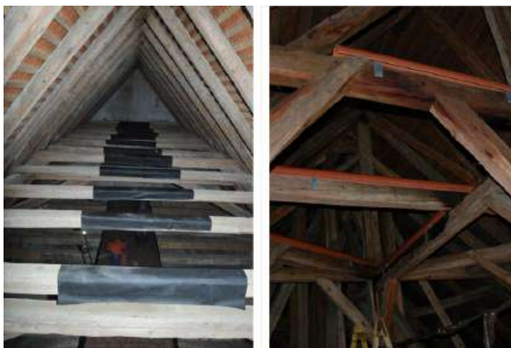
Obr. 3.16: Ochrana hambáľkov nad podlahou pomocou pruhy z DTB fólie (←). Ochrana horizontálnych trávov z rozpolených PVC trubiek (→).
