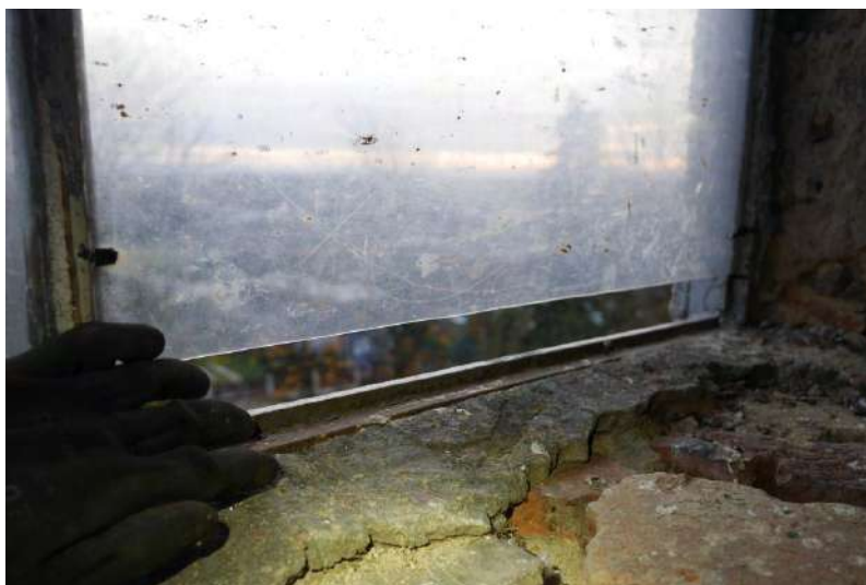
Obr. 6.42: Vletový otvor zmenšený plexisklom.
