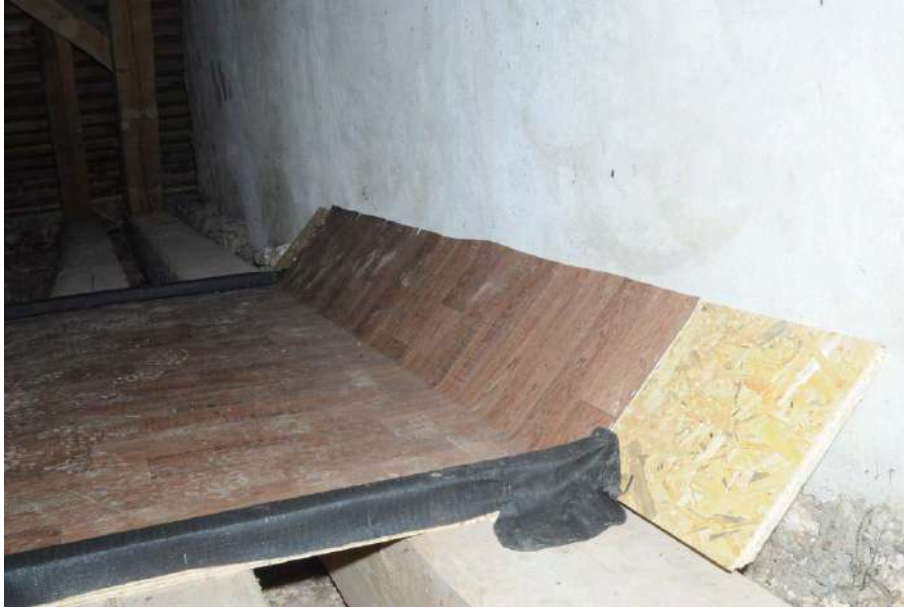
Obr. 3.11: Podlážka potiahnutá linoleom — jej začiatok pri stene zošikmený, aby pri jej okraji nezapadával netopierí trus. Pri takomto ohybe musí byť linoleum starostlivo stlačené do kúta než ho pripevníte, aby sa neskôr nezačalo trhať. Na podlážke je už nainštalovaný zvýšený okraj, ktorý je výhodné pripevňovať až na vrch na linoleum.
