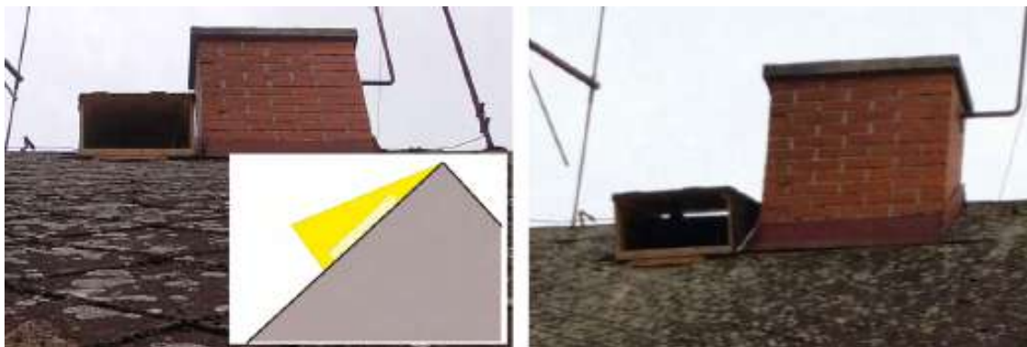
Obr. 6.34: Odklápací vikier umožňuje prístup netopierov do podkrovia.
