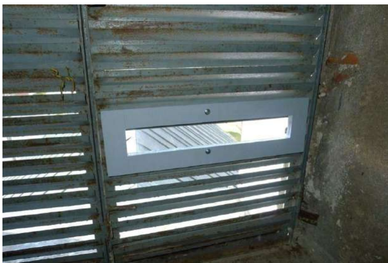
Obr. 6.39: Vletový otvor v kovových žalúziách.
