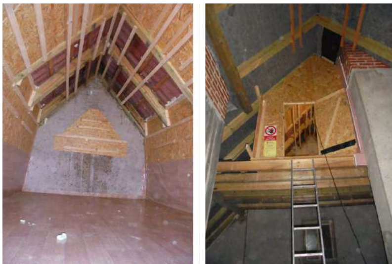
Obr. 6.15: Vnútrotný priestor budy, kde je podlaha zakrytá linoleom a v hornej časti sú pre netopiere pripravené laty na zavesenie. Zadná časť je teplejšia a sú v nej odkryté škridle, v prednej časti je strop budy zakrytý OSB doskami tak, že za nimi prúdi vzduch — to spoločne s múrom komína túto časť ochladzuje (←). Pohľad na umiestnenie budy na hambáľkoch v podkroví. Inventarizačný otvor sa uzatvára a je zaistený visiaticim zámkom (→).
