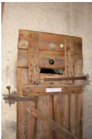
Obr. 6.37: Vletové otvory umiestnené do dverí.
