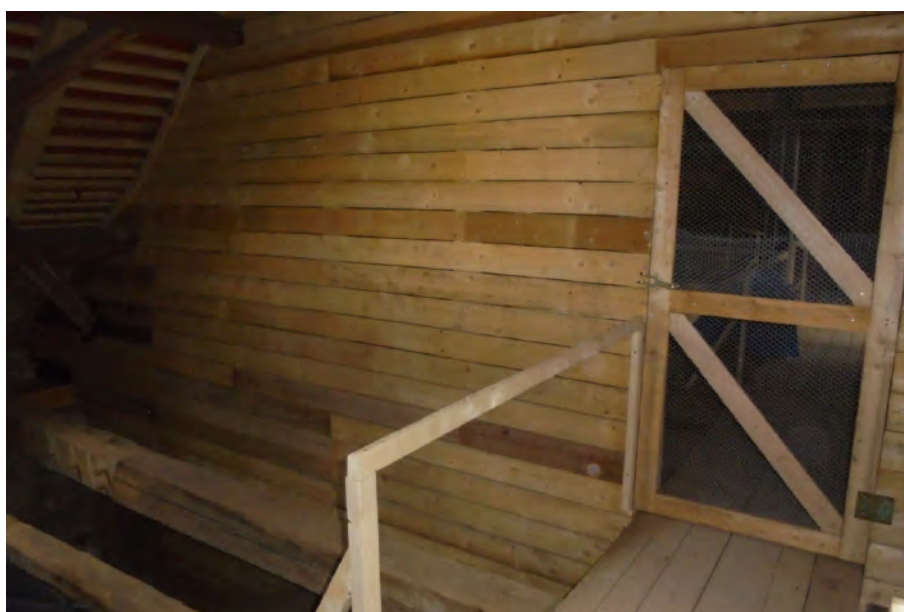
Obr. 4.2: Predelenie podkrovného priestoru doskovou stenou. Vo dverách a pri štíte je pletivo, ktoré zaisťuje prirodzené prúdenie vzduchu - mikroklima teda ostáva nezmenená.
