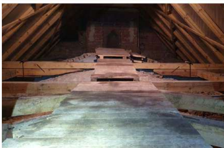
Obr. 6.19: Pôchodzna lávka a jej okolie znečistená od guána (↑). Použitie priemyselného vysávača - praktickej pomôcky na čistenie takto málo znečistených priestorov (stred). Výsledný stav po vyčistení podkrovia a povysávaní lávky (↓).
