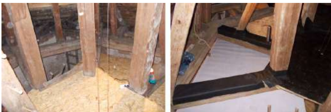
Obr. 6.13: Pohľad na inštalované OSB dosky v druhej a tretej úrovni. To isté miesto, ale už pokryté linoleom (←). Tretia úroveň je zakrytá čiernym a druhá bielym linoleom (→).
