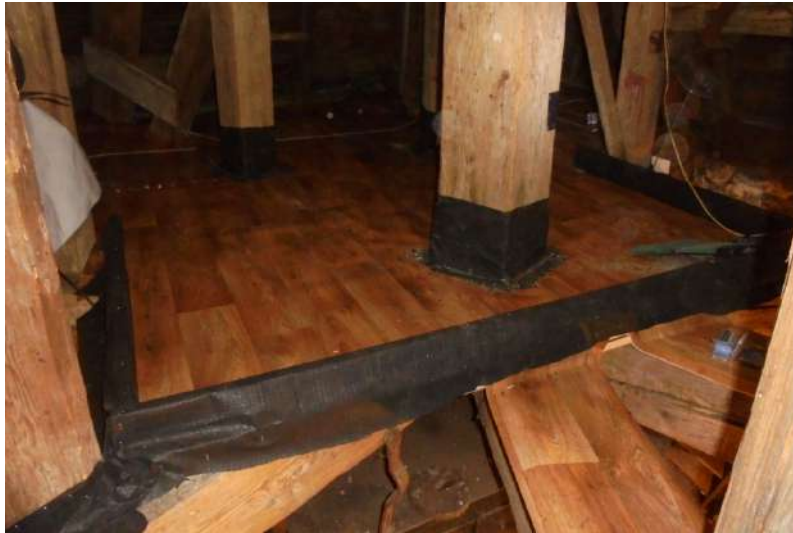
Obr. 6.10: Podlážka nad hodinami je lemovaná 10 cm širokým okrajom. Po prvej sezóne sa ukázalo, že táto výška okraja podlahy bola správne odhadnutá. Stojky prechádzajúce podlážkou sú taktiež opatrené ochranným golierom.
