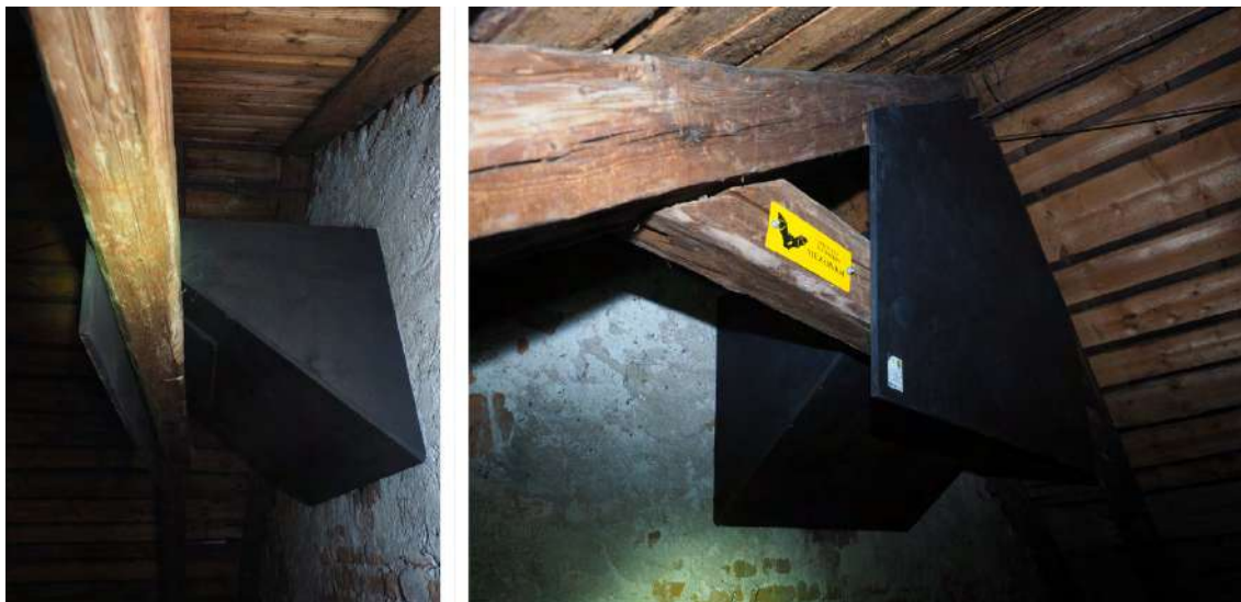
Obr. 6.43: Kryt skonštruovaný z drevených dosiek s tmavým náterom v podkrovní Cisterciánskeho opátstva vrátane tieniacej clony do interiéru úkrytu.
