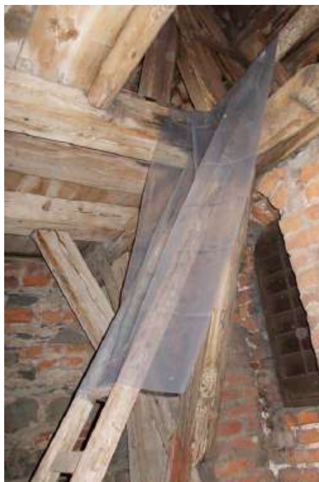
Obr. 6.46: Tento pruh igelitu nie je inštalovaný kvôli zachytávaniu guána — má iný účel. Na lokalite bol problém s kunami, ktoré zabíjajú netopiere. K netopierom sa však kuny mohli dostať len po rebríku. Klzký 1,5 metra dlhý igelit je pre akúkoľvek kunu neprekonateľná prekážka (Frýdlant; CZ).
