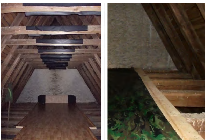
Obr. 6.6: Pásky ochrannej fólie na hambáľkoch (←). Natiahnutá plachta (2×8 m), pozdĺž ktorej je lávka z dosiek, aby sa dalo upratovať guáno.
