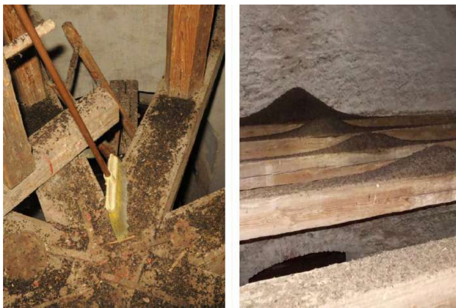
Obr. 2.2: Netopierie guáno v tenších vrstvách dobre presychá, hrubšie vrstvy však zadržujú vlhkosť. V prípade, že je takáto kopa na niektorej drevenej konštrukcii, tak predstavuje značný problém. V niektorých prípadoch postačí pravidelné ometanie (←), v iných je potrebné po odpratání guána trámy zakryť ochranou (→).
