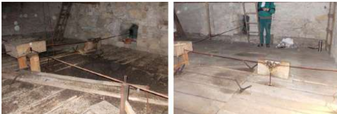
Obr. 6.12: Najnižšia úroveň pred realizáciou upratovania. Na prvý pohľad tu je malá vrstva trusu, pretože vlastník si to čistil sám, aby udržal mechanizmus hodín v prevádzke (←). Uprataná plocha najnižšej úrovne — je vidieť, že priestor je tu nízky. Následne sa celá plocha zakryla DTB fóliou (→).
