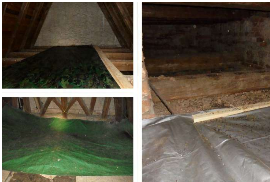
Obr. 3.19: Plachta ukotvená pomocou lát k hambáľkom — tu postačuje kotvenie len na koncoch plachty — dlhšie pozdĺž plachty je umiestnená látka z fošny pre zaistenie prístupu pri upratovaní.
