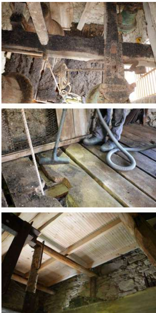
Obr. 6.24: Pôvodný stav znečistenia veže kostola od guána (↑). Dočistenie priestoru pod podlážkou a pod zvonmi priemyselným vysávačom (stred). Podlážka na záchyt guána vybudovaná nad konštrukciou zvonov (↓).
