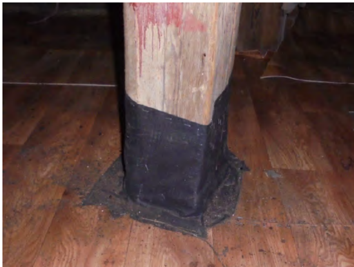
Obr. 3.15: Ochranný golier z DTB fólie na stojke prechádzajúcej podlážkou.
