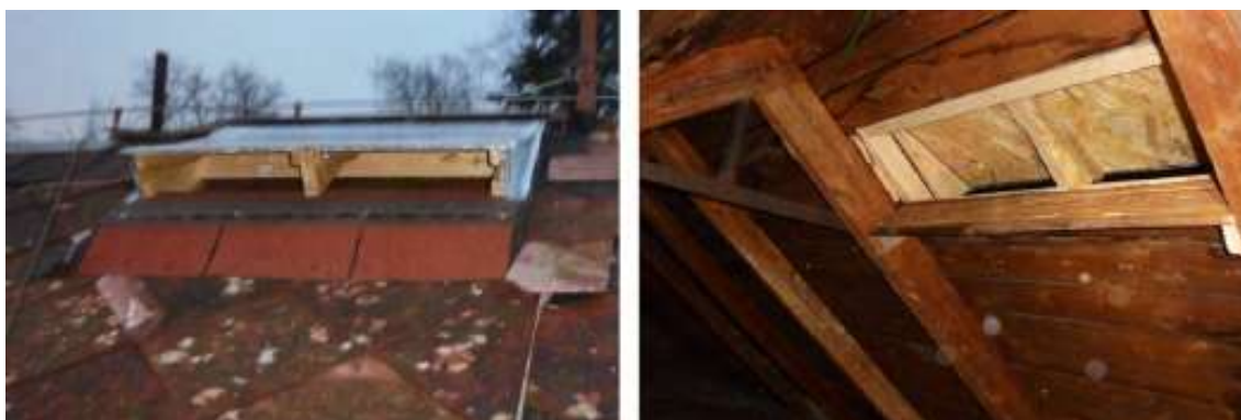
Obr. 6.35: Vikier ako náhrada za zaniknutý vletový otvor.
