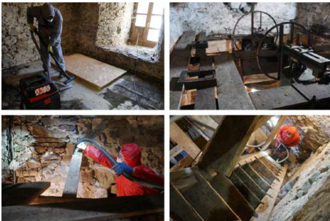
Obr. 6.21: Dôkladné čistenie pomocou priemyselného vysávača.
