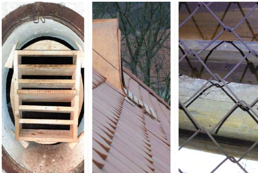
Obr. 4.3: Žalúzie inštalované do vletového otvoru zamedzujú vstupu holubom. Tieto žalúzie sú upevnené iba pomocou malých drevených klinov — vďaka tomu môžu netopiere preliezať aj po stene okolo žalúzií (←). Latový rošt umiestnený pri vletovom otvore kolónie netopiera veľkého na novej glazovanej strešnej krytine (stred). Ohrdzavené pletivo nepôsobí netopierom žiadny problém pri preliezaní (→).
